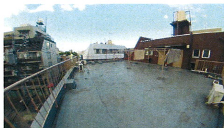
■屋上・物干場■
